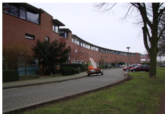
Nieuwbouw aan de Jachthoornstraat
