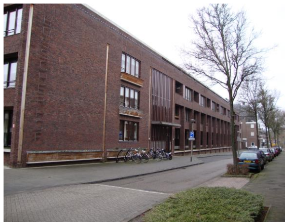
Nieuwbouw Bosscherhof (Voedingskanaalweg)
